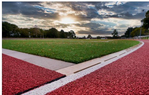
BU: Hohlprofilrinnen leiten das Regenwasser effizient ab.
