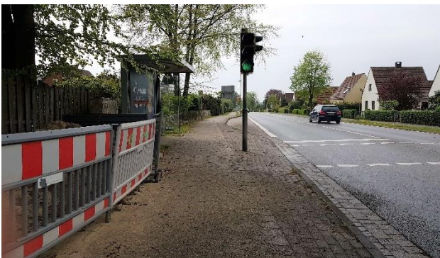
Haltestelle an der Stader Landstraße, ausgestattet mit Witterungsschutz, aber weit entfernt von der Busbucht, nicht barrierefrei
