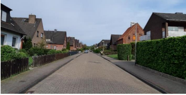
Schmaler Gehweg auf Hauptroute zum Bahnhof, Findorffstraße
