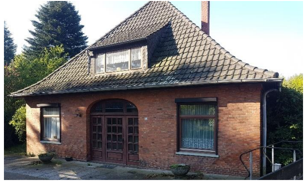
Individuelles Einfamilienhaus am Mühlenberg
