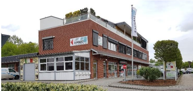
Gewerbegebäude aus den 1980er Jahren
