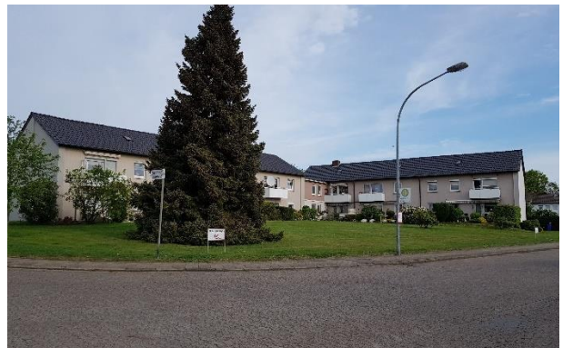
Geschosswohnungsbau der 1960er Jahre am Mühlenberg
