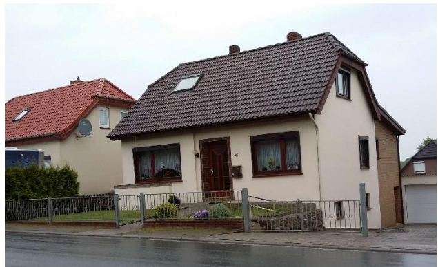
Bebauung aus den 1950er Jahren an der Neuen Landstraße
