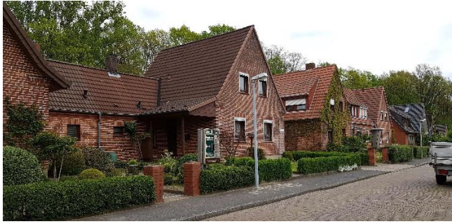
Gut erhaltene Siedlungshäuser Am Großen Geeren
