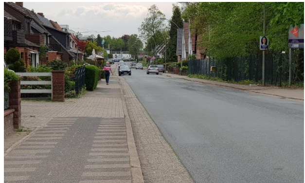
Fehlender Radweg Am Großen Geeren
