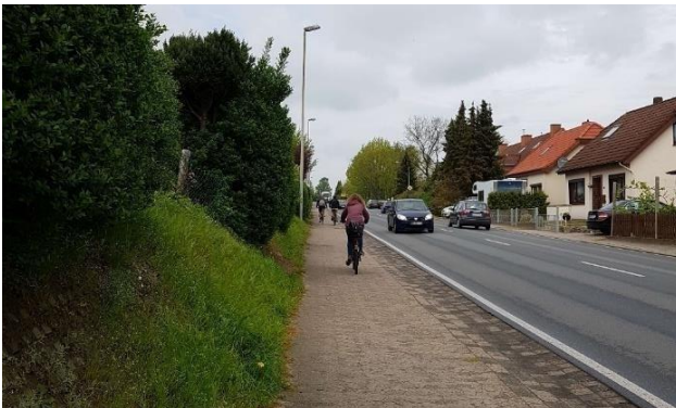
Einseitige schmale Radwegführung an der Neuen Landstraße
