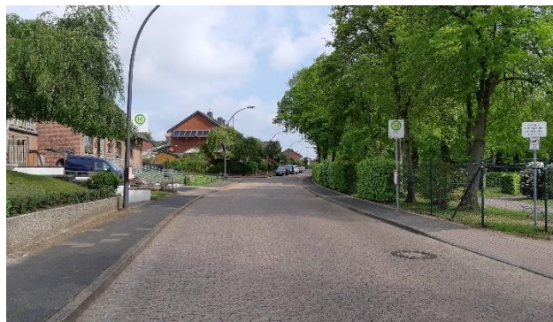
Bürgerbushaltestelle am Friedhof, an schmalen Gehweg ohne Wartefläche, Witterungsschutz, Sitzgelegenheit und nicht barrierefrei
